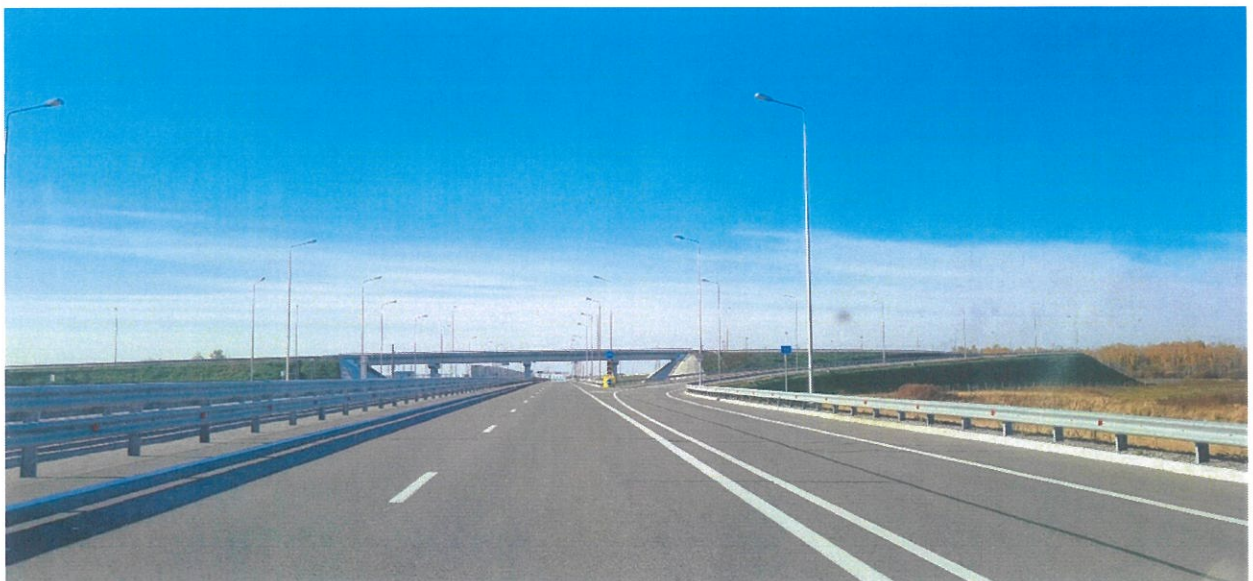
Фото №17. Нанесена горизонтальная дорожная разметка км 19 основной ход (обратное направление)
