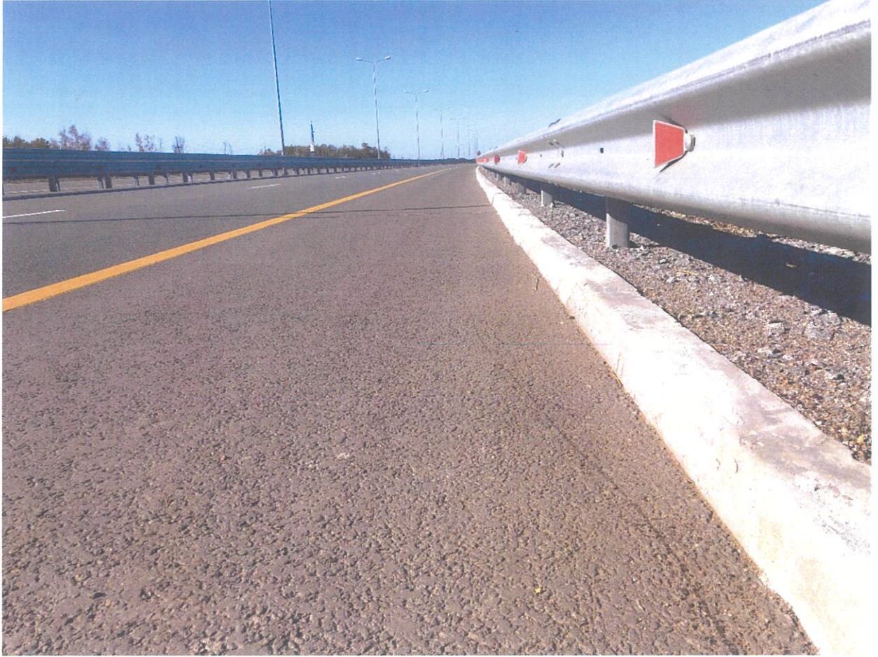
Фото №12. Выполнены работы по восстановлению бордюрного камня
