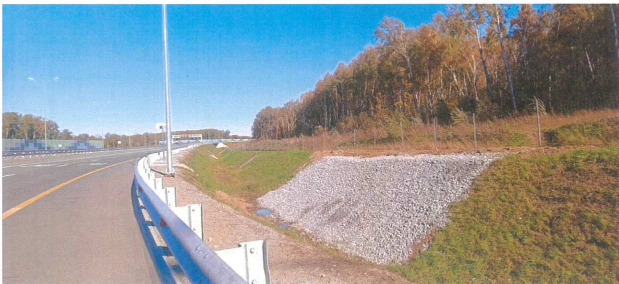
Фото №6. Выполнены работы по восстановлению откосов земляного полотна
