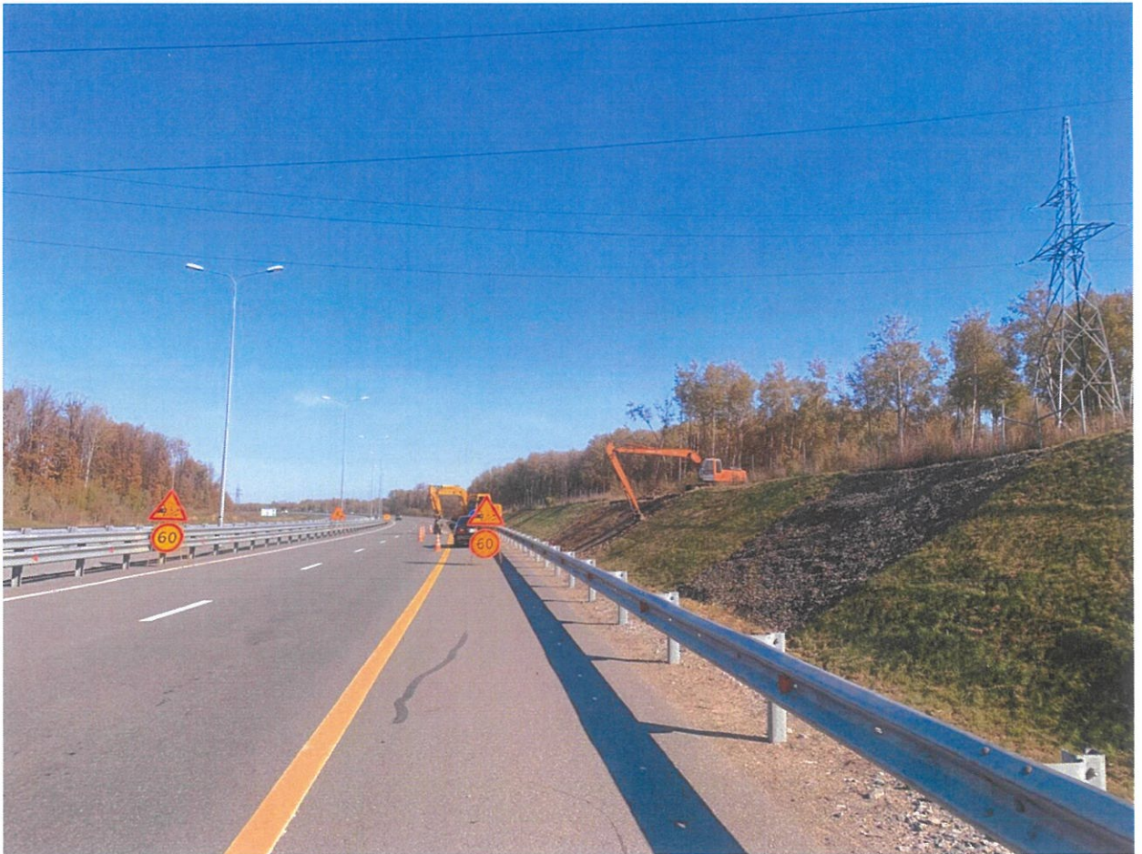
Фото №4. Выполнение работ по восстановлению откосов земляного полотна
