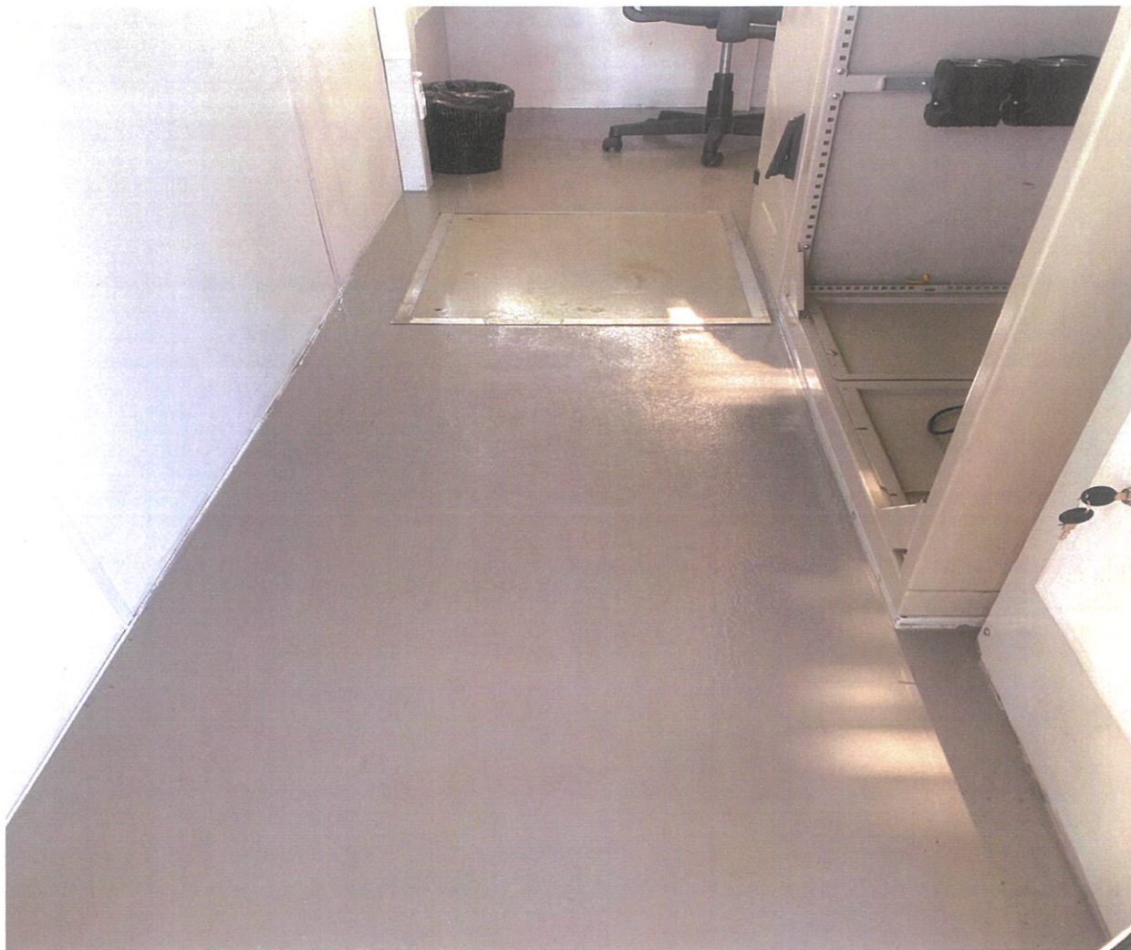
Фото №20. Выполнены работы по ремонту покрытия в кабинах оператора ПВП №1 - №5
