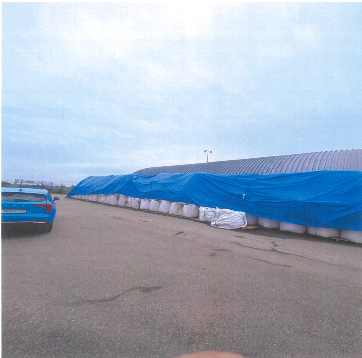
Фото №21. Склад хранения реагента «Бионорд» в районе ПВП №3 Объекта
