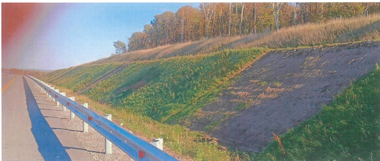
Фото №7. Выполнены работы по восстановлению откосов земляного полотна
