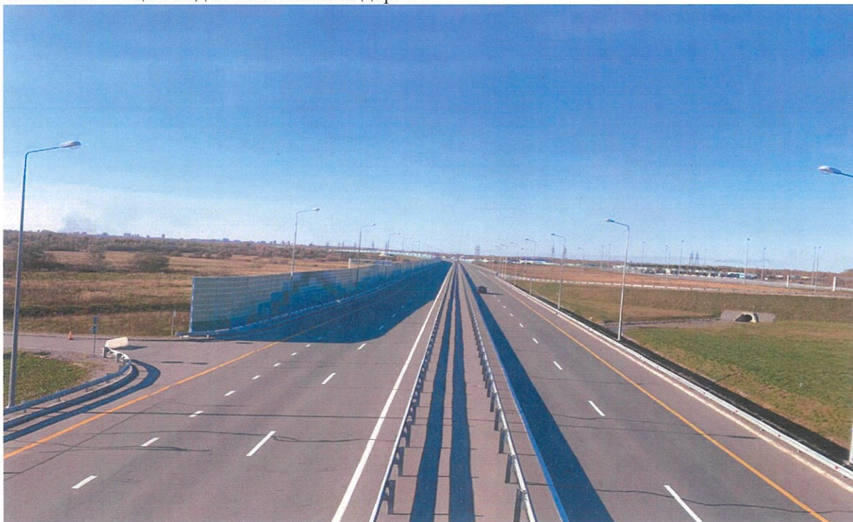
Фото №2. Общий вид автомобильной дороги
