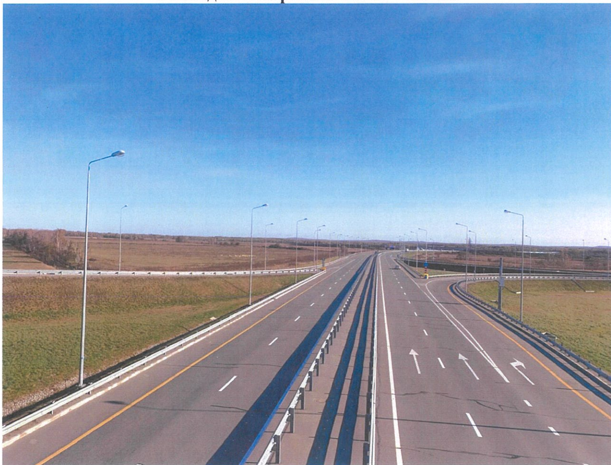
Фото №1. Общий вид автомобильной дороги
