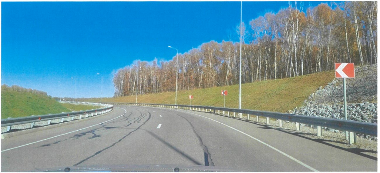
Фото №15. Выполнены работы по герметизации трещин в асфальтобетонном покрытии битумно-полимерным герметиком ТР6 (съезд №1)
