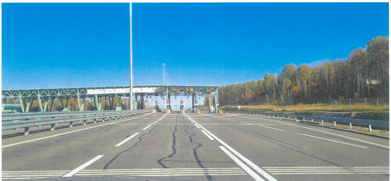
Фото №14. Выполнены работы по герметизации трещин в асфальтобетонном покрытии битумно-полимерным герметиком зона ПВП №5 км 37 обратный ход
