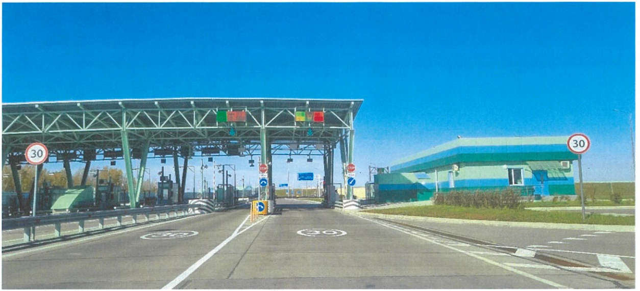
Фото №3. Общий вид здания ПВП км 17
