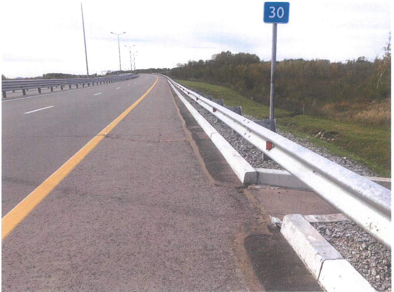
Фото №13. Выполнены работы по замене бордюрного камня
